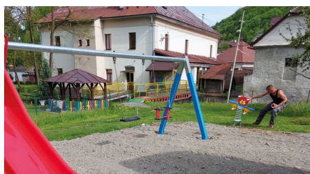
Rekonštrukcia detského ihriska v materskej škole
